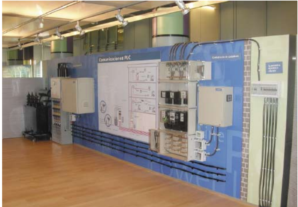
Figura 3. Centro de pruebas de PLC de Endesa.
